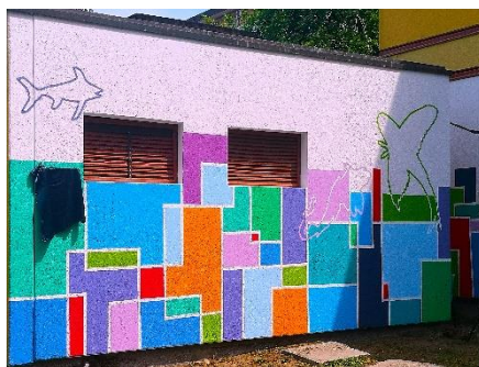
Parte del murales che corre tutto intorno al plesso e continua negli spazi interni
