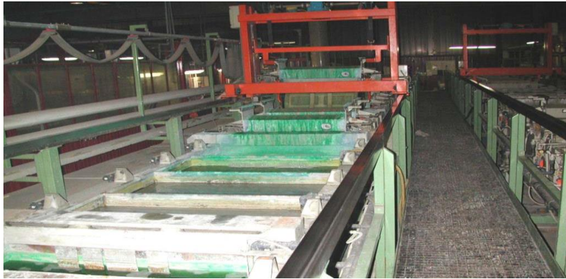
Vasche con bagno galvanico
